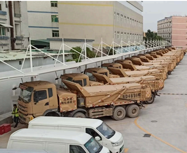
深圳银河充电站项目
